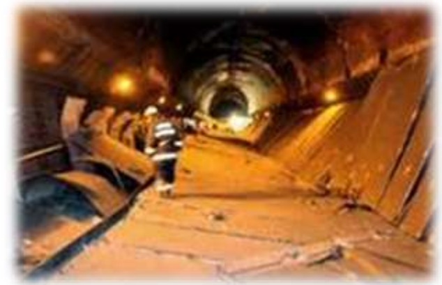
笹子トンネル事故 (2012年12月)
