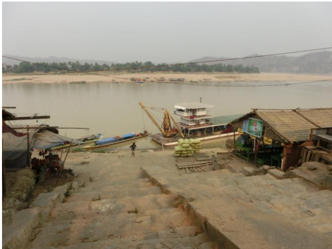
河岸（港湾）の状況（カレワ港）
