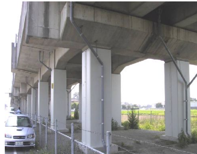
Aseismic reinforce of Viaduct columns
