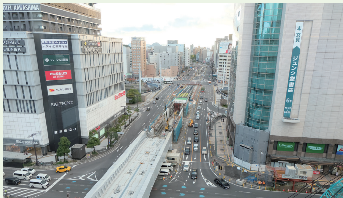
路面電車乗り入れ区間の工事状況
