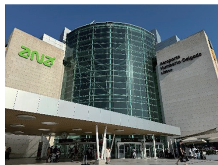
リスボン国際空港の建物
