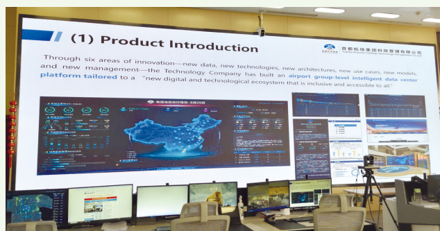
同データセンター内の大画面
