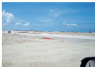
図7 造成中の土地
