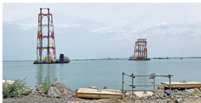
図3 工事の状況（2023年筆者撮影）
