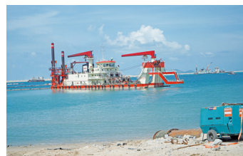
図8 作業を行う浚渫船
