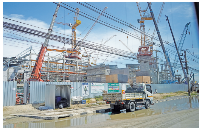
図10 建設中の施設
