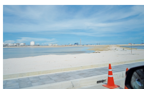
図6 整備中水域と資源貯蔵施設
