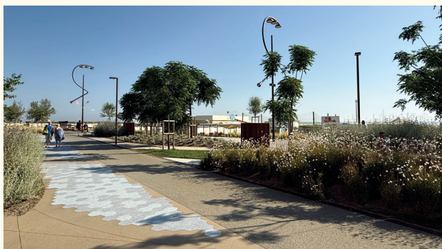
再整備後の海岸通り（車道からプロムナードへ）
