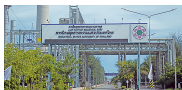
図5 港湾区域の入口
