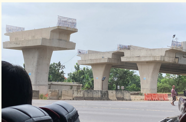
建設中のアクセス高速道路
