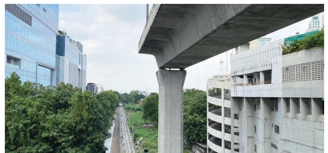
図8 ARLパヤタイ駅 ドンムアン方高架橋端部
