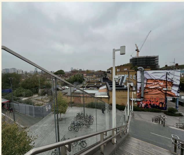
図-19 Custom House 駅周辺。建設中のビルが見える。
