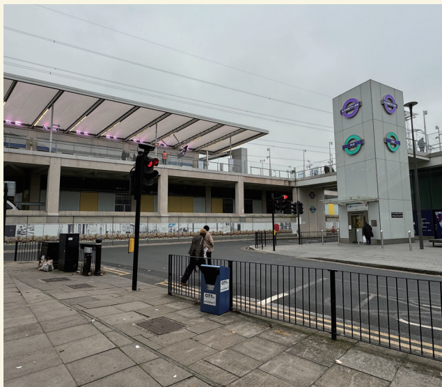
図-17 Custom House 駅周辺
