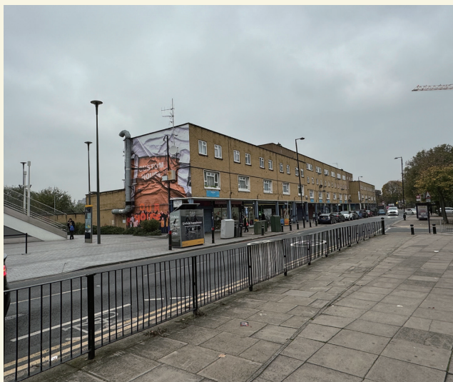
図-18 Custom House 駅周辺
