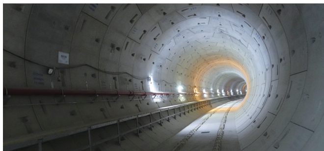
ジャカルタ MRT 南北線フェーズ2モナス駅建設現場・シールド区間
