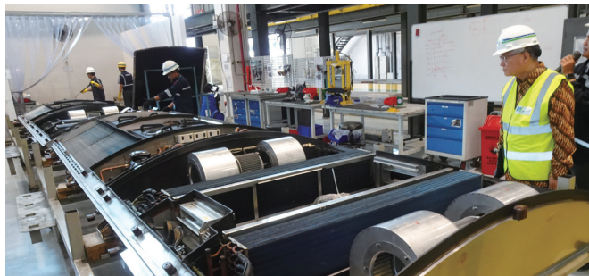
ジャカルタ MRT 車両基地内での整備
