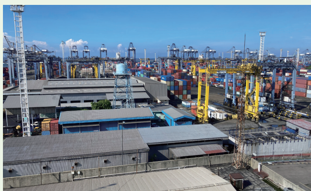
図4：JICTコンテナヤードの様子
