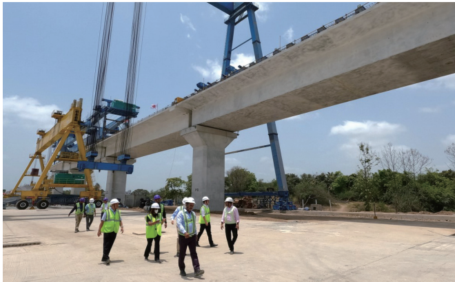
ムンバイ・アーメダバード間高速鉄道の建設現場
