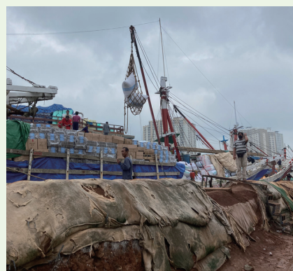
図7：岸壁の状況と荷役の様子
