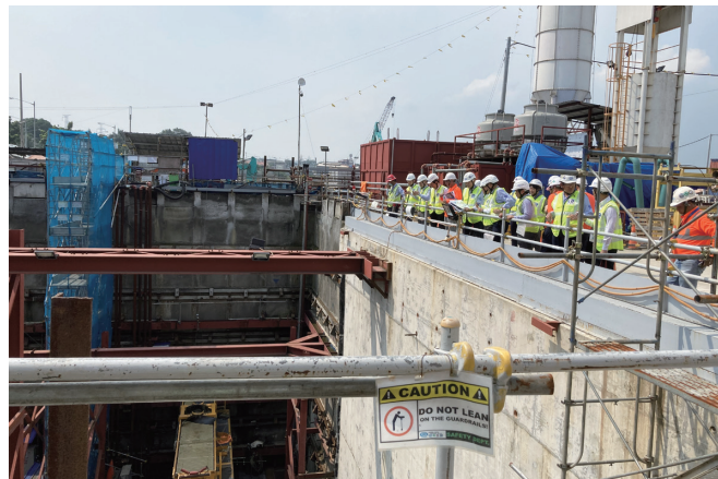
写真5 TBM発進立坑の外観
