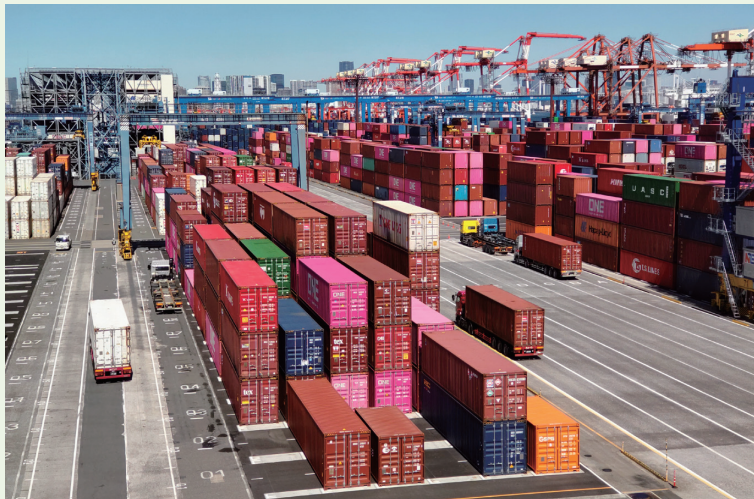
日本郵船東京コンテナ・ターミナル
