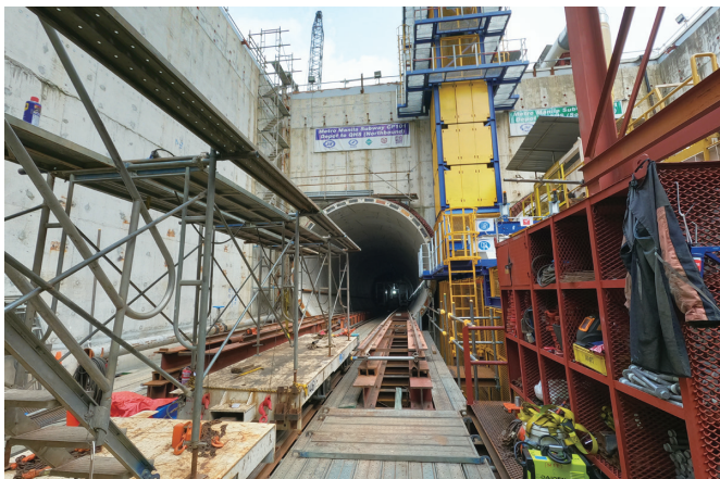
写真6 TBM発進立坑内の様子
