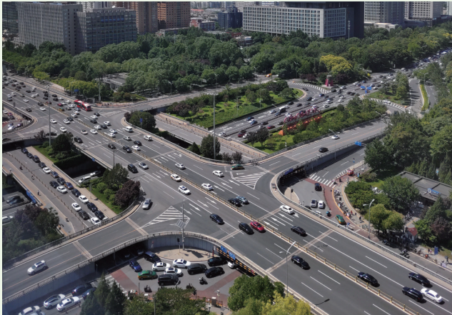
市中心部の骨格道路（片側4車線）
