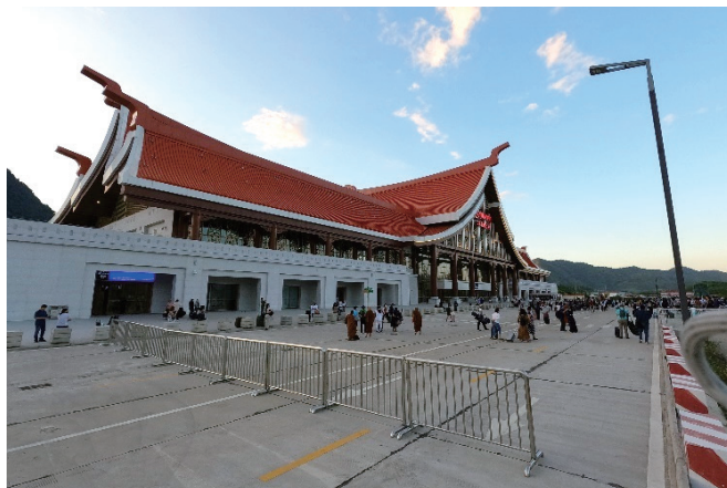
写真-7 ルアンパバーン駅外観
