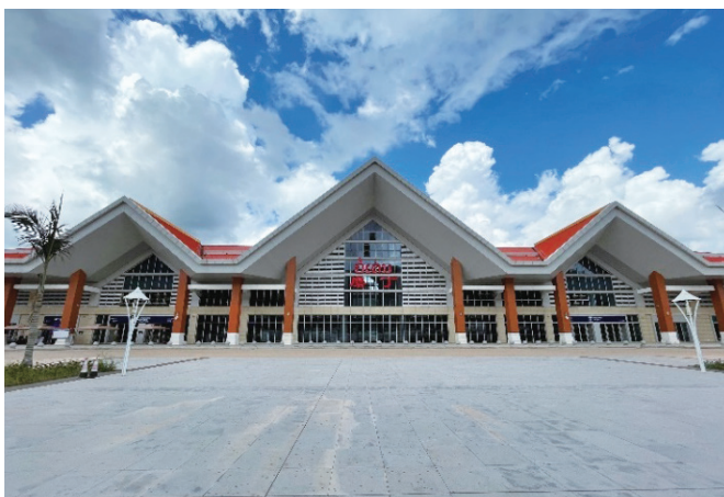
写真-12 ボーテン駅外観
