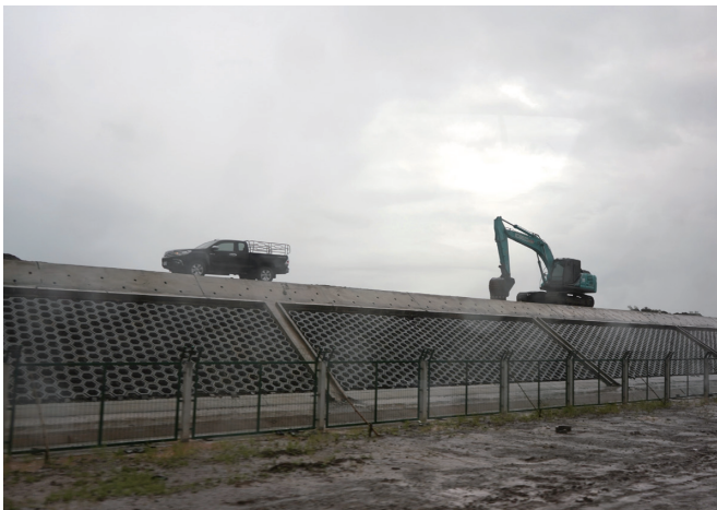
写真-3 のり面がコンクリートと植生用ブロックで保護されている土工区間
