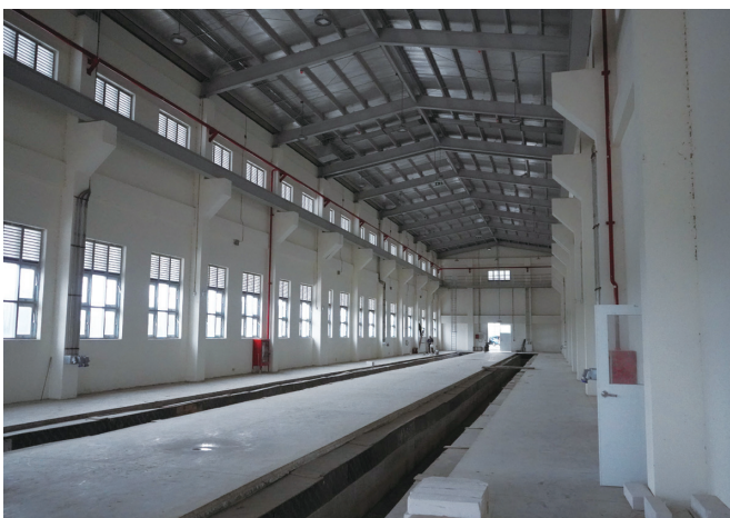
写真-5 屋内メンテナンス施設
