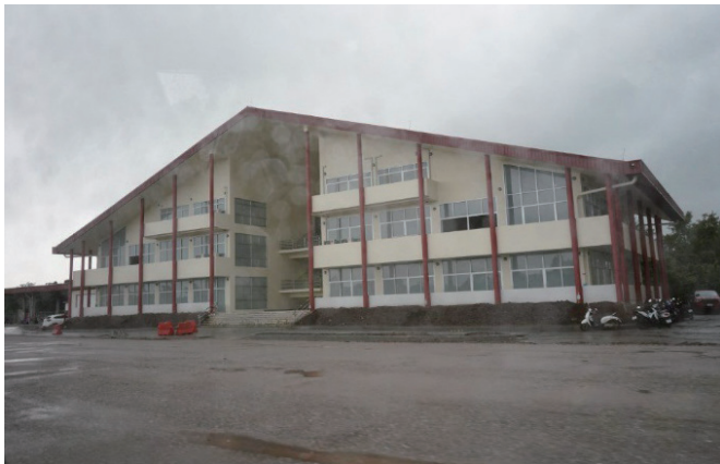
写真-7 オペレーション施設
