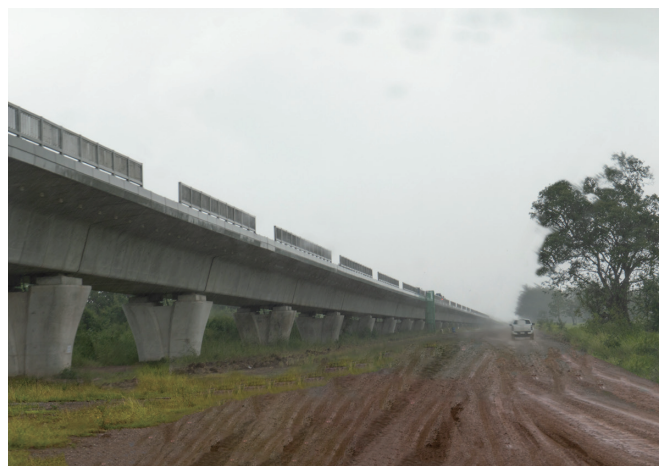
写真-2 土工区間に向けて柱の高さが低くなっている高架区間
