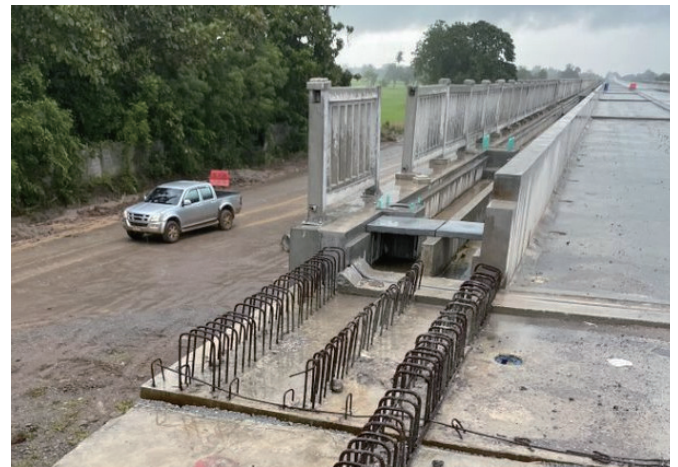
写真-4 高架区間と土工区間の境界部におけるダクト施工の様子
