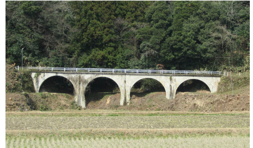
▲島根県浜田市：幻の広浜鉄道（未成線）
