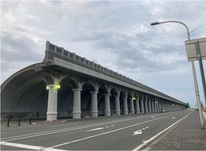
▲北海道稚内市：北防波堤ドーム
