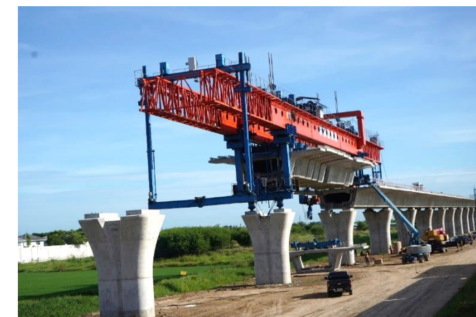
高架区間の工事の様子(2023年7月撮影)
