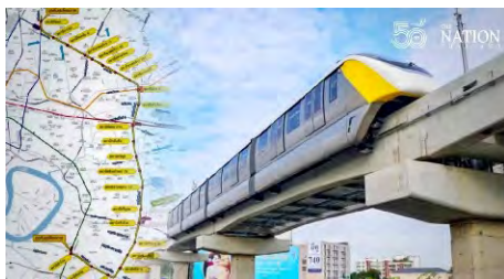
建設中 : Yellow Line
