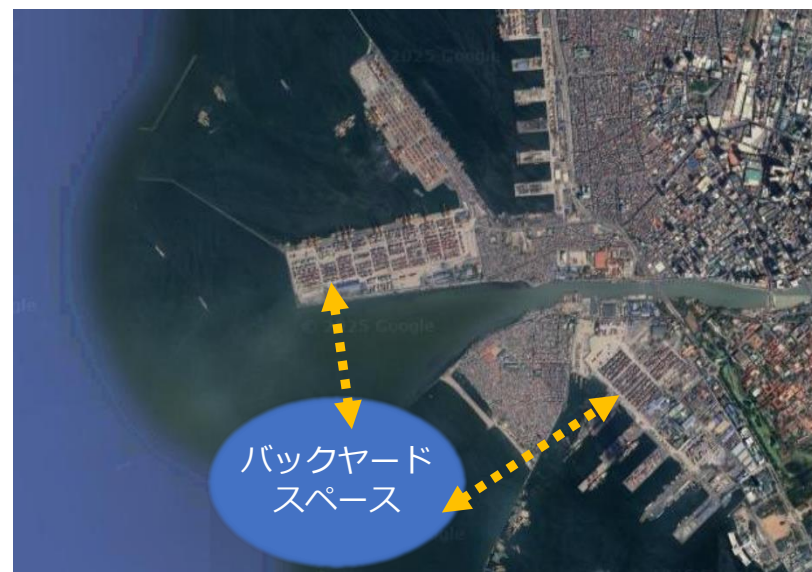
バックヤードスペースの確保 supported by THE NIPPON 財団 FOUNDATION
