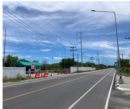
図4 エアポートシティ建設予定地の様子（土地造成はまだ始まっていない状態で、樹林地が広がっている） (2026 年筆者撮影)
