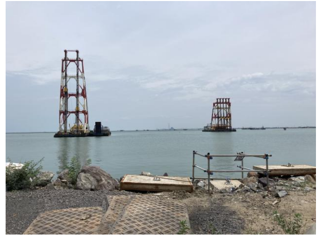
図3 工事の状況 (2023年筆者撮影)
