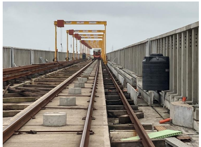
図7 本線内の仮軌道敷設
