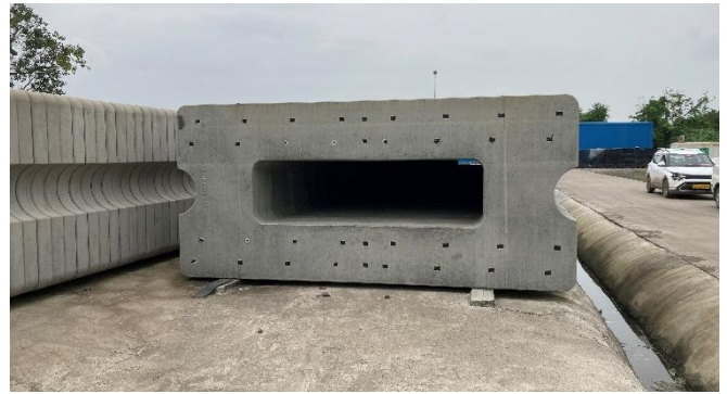
図6 軌道建設基地における軌道スラブ保管
