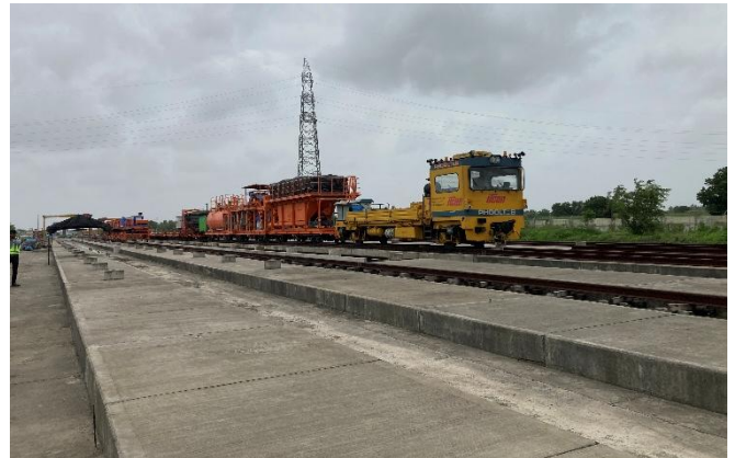
図8 教育訓練施設における訓練線と軌道工事車両
