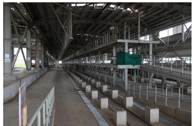
図5 スーラト車両基地内の建築工事および設備基礎工事
