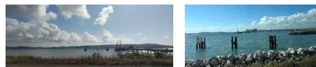
グラッドストーン港の概観
