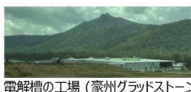
電解槽の工場 (豪州グладストーン)
