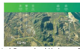
Central Queensland Hydrogen Project (CQ-H2) 概観 (豪州グладストーン)
